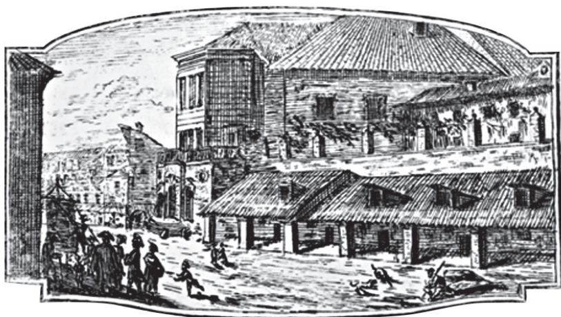
L'antico piazzetto del Mecato del Vino, ora Corso Zanardelli, lato ingresso del Teatro Grandi/Le botteghe dei lapicidi erano nel porticato sottostante le mura viscontee. Acquaforse di Giovan Battista Carboni, 1760.
